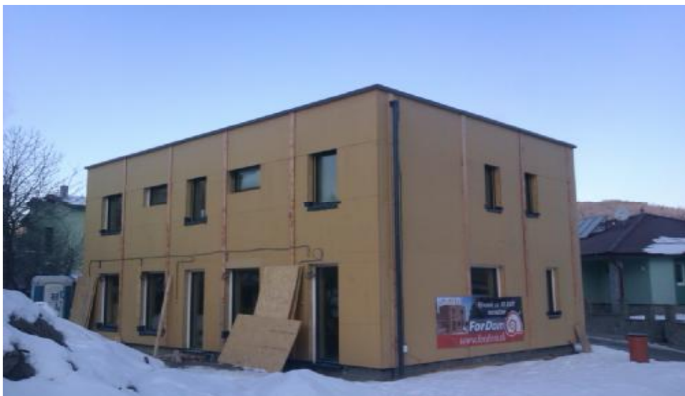
Obr. 2 Ecocube Max v Starej Kremničke, štádium hrubej stavby
