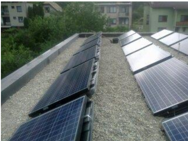
Obr. 8 Fotovoltaické panely na streche Ecocube Max
