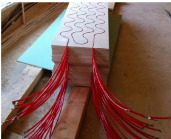
Obr. 7 Prvky stenového teplovodného vykurovania a schéma ovládania z jedného bodu.
