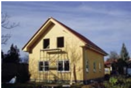
Obr. 3 Montovaný rodinný dom s drevenou rámovou stĺpikovou konštrukciou
