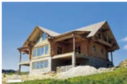
Obr. 1, 2 Drevostavba na kamennej podmurovke
