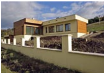
Obr. 4 Drevenostavba v nízkoenergetickom štandarde
