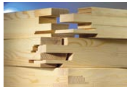
Obr. 10 Detail spoja dreveného rámu okna
