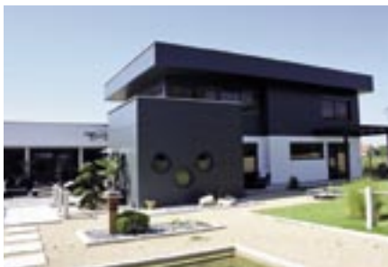
Obr. 5 Drevenostavba v pasívnom štandarde
